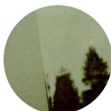
Quando existe pouco poder de cobertura, ou opacidade, a cor da tinta de acabamento não é uniforme. O aparecimento deve-se à utilização da tonalidade do aparelho, na escala de cinzentos, inadequada para a cor final, ou à insuficiente espessura de aplicação da tinta de acabamento. A solução do defeito obriga a despolir a zona afetada e repintar.
